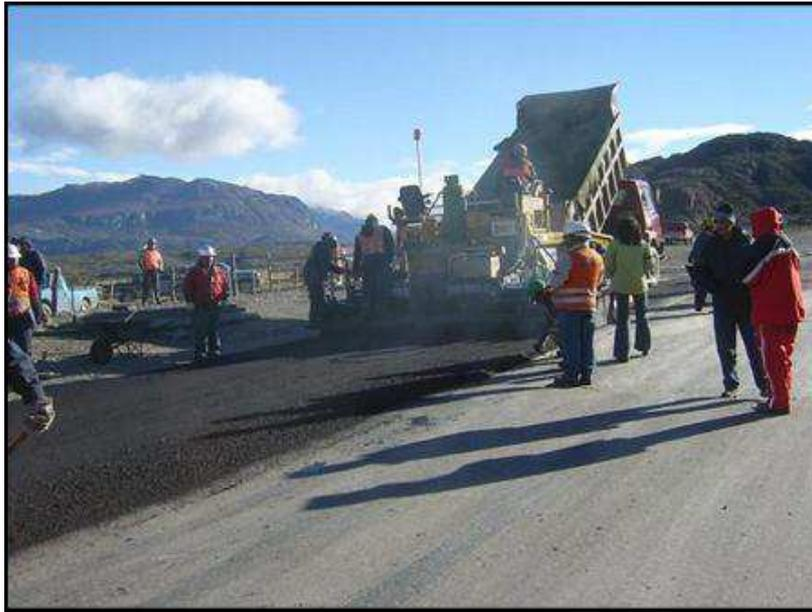
Figura 2.18 Puesta en obra mezcla asfalto caucho (Fuente Ávila 2005)
