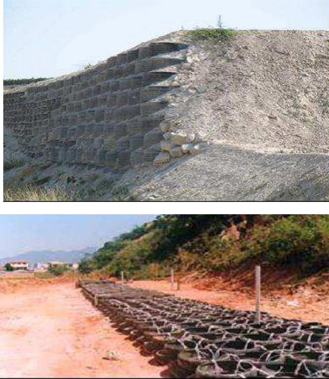
Figura 2.11 Muro de contención con neumáticos usados
