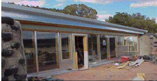
**Figura 2.13 Construcción de cimientos y muros de viviendas con neumáticos usados**
